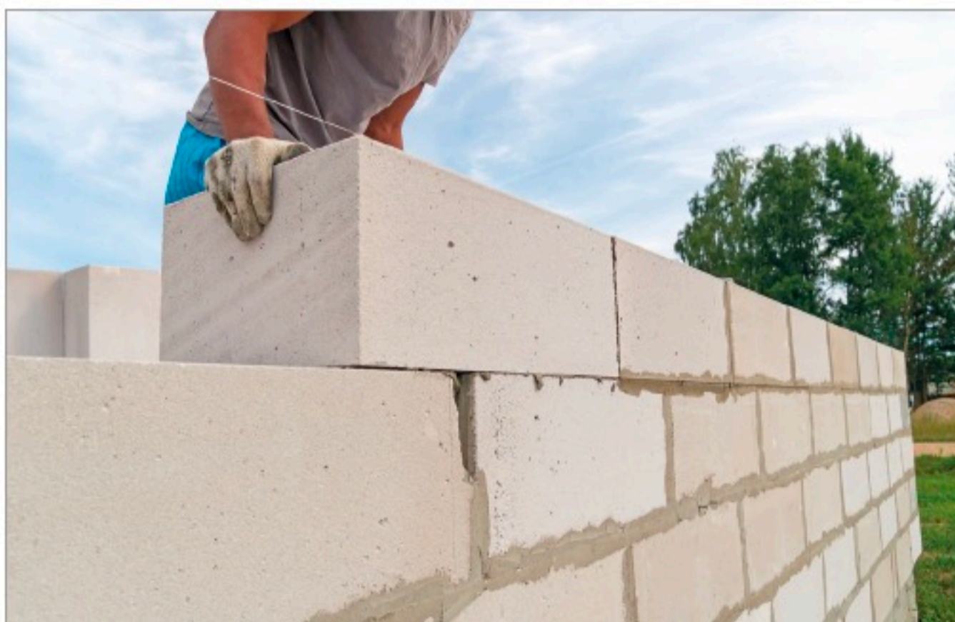
Här muras en innervägg av murblock.
