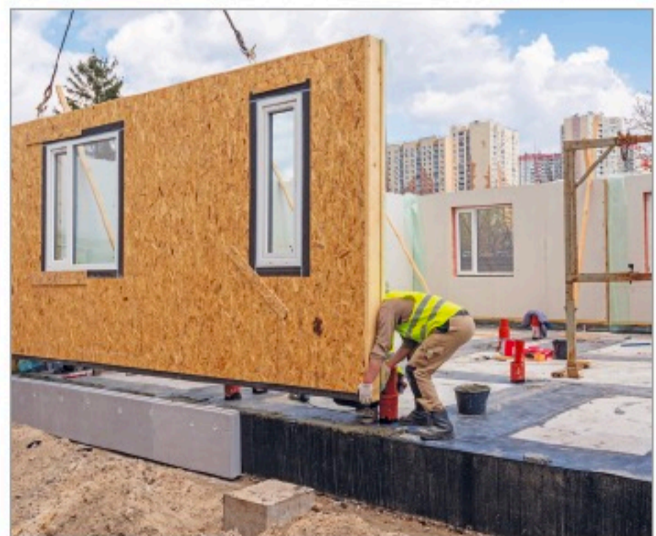
Montera väggar som kommer färdigbyggda från fabrik.
