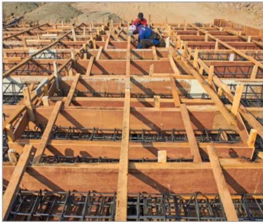
Bygga en form att gjuta betonggolv i.
